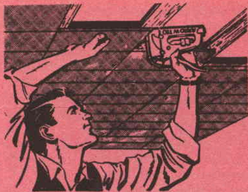
Posa di un soffitto decorativo.
